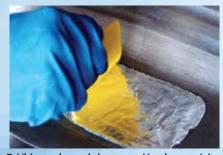
7. Ubique el panel de reparación de propósito múltiple #828 MAXIM dentro del perfil. Presione firmemente el borde posterior del parche hasta el sustrato de modo que el uretano no salga de debajo del parche de reparación. Suavice el centro del parche con una espátula.
