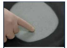
3. Deje secar 15 minutos y aplique un imprimador para superficie según las recomendaciones del fabricante de la pintura.
